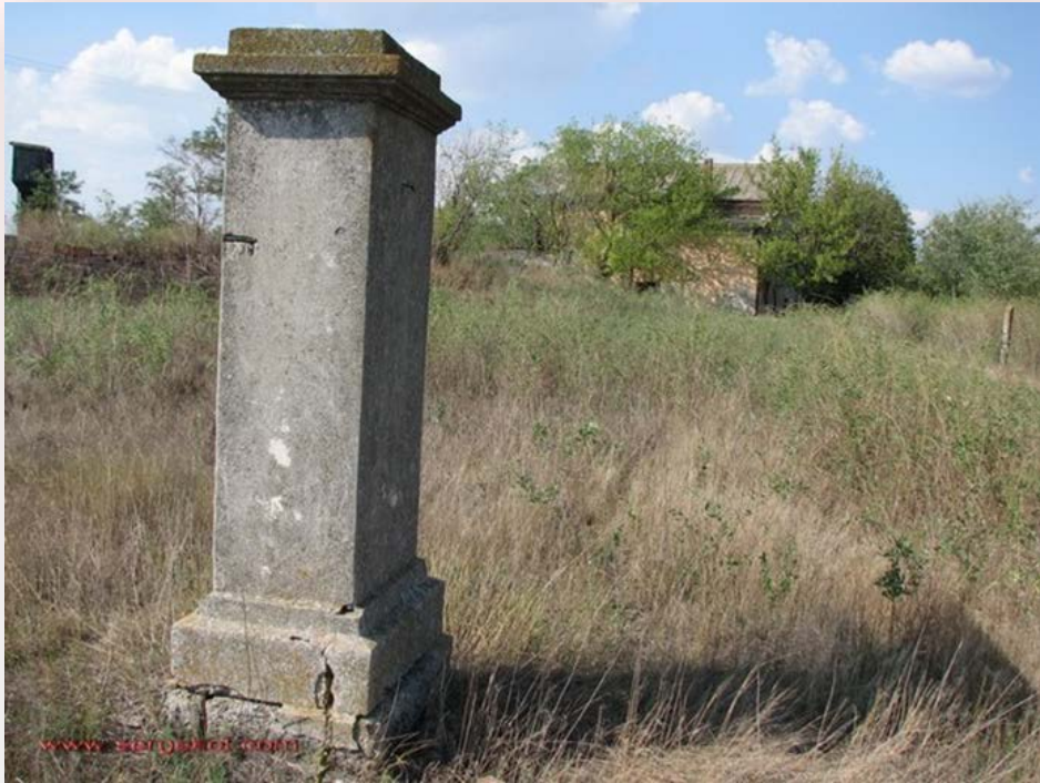
Вентиляційна шахта льоху, де проводились магнітні вимірювання
