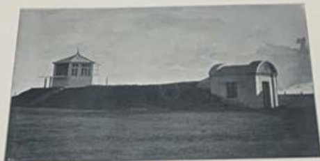
Pavillon isolé pour un magnétographe photographique.
